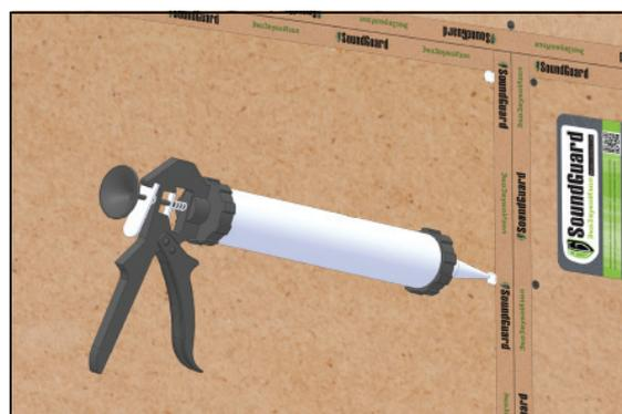
**7** Места стыков панелей между собой и швы при закрытия к полу, стенам и потолку при помощи шпателя или монтажного пистолета заполняются герметиком **SoundGuard Seal**, желательно не ранее, чем через 24 часа после монтажа, и проклеиваются самоклеющейся лентой **SoundGuard Tape**.
