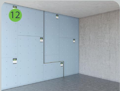
Звукоизоляционный гипсокартон SoundGuard Gipsofon монтируется без зазоров между листами. Расход саморезов SoundGuard ГП 3,9x30 составляет не менее 22 шт./м<sup>2</sup>.
