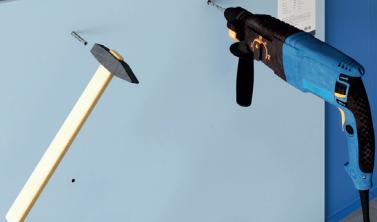
Звукоизоляционный гипсокартон SoundGuard Gipsofon монтируется к стене универсальными саморезами SoundGuard УН 4х80 с дюбелями SoundGuard DR 6x60 с предварительным засверливанием. Расход составляет не менее 22 шт./м<sup>2</sup>.
