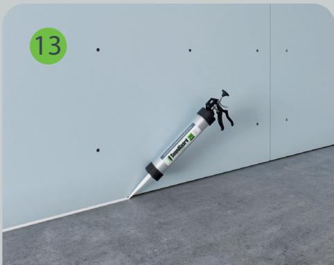
Между торцами листов гипсокартона и поверхностями пола, стен и потолка остается зазор 3 – 5 мм, который впоследствии заполняется герметиком SoundGuard Seal.
