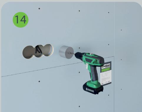
После монтажа звукоизоляционного гипсокартона SoundGuard Gipsofon в нем коронкой просверливается отверстие в месте установки подрозетника.
