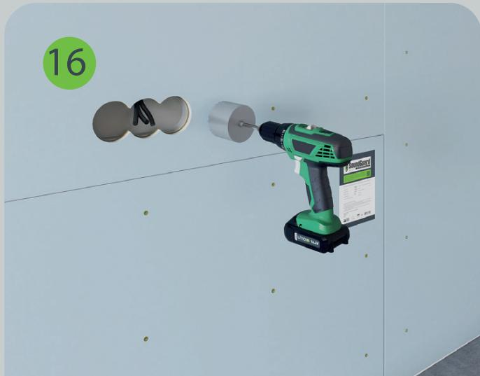
После монтажа звукоизоляционного гипсокартона в нем коронкой просверливается отверстие на месте установки подрозетника SoundGuard ИзоБокс Премиум. Электрический подрозетник прикручивается к внутренней плоскости короба саморезами.
