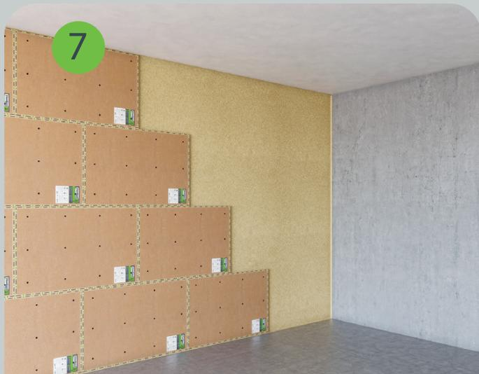
Звукоизоляционные панели SoundGuard ЭкоЖвукоИзол устанавливаются вразбежку и крепятся к стене с помощью акустических дюбель-гвоздей SoundGuard DA-P.
