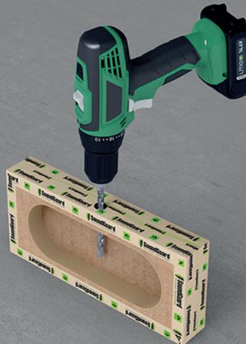
В подрозетнике SoundGuard ИзоБонс Премиум просверливается отверстие для выпуска проводов. Место выхода электропровода заполняется герметиком SoundGuard Seal.
